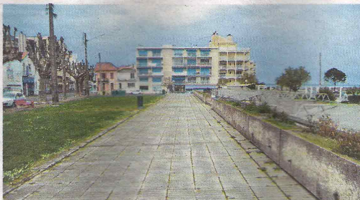
Avec le port et le Bassin en face, le Petit port d'Arcachon, site sélectionné pour accueillir le Pôle Océanographique Aquitain. Une fois démarrés, les travaux dureront entre 24 et 36 mois.
